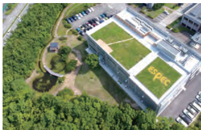
エスバックミック施工の屋上緑地
