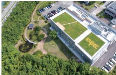
エスバックミック施工の屋上緑地
