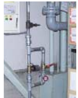
圧縮空気配管に電磁弁を取り付け、業務終了・非使用回路は自動的に遮断する
