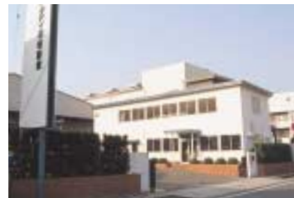
■ 株式会社タバイ環境設備 (大阪府大東市)
