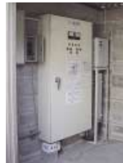
24時間稼働している工業用ポンプに、インバータを取り付け
