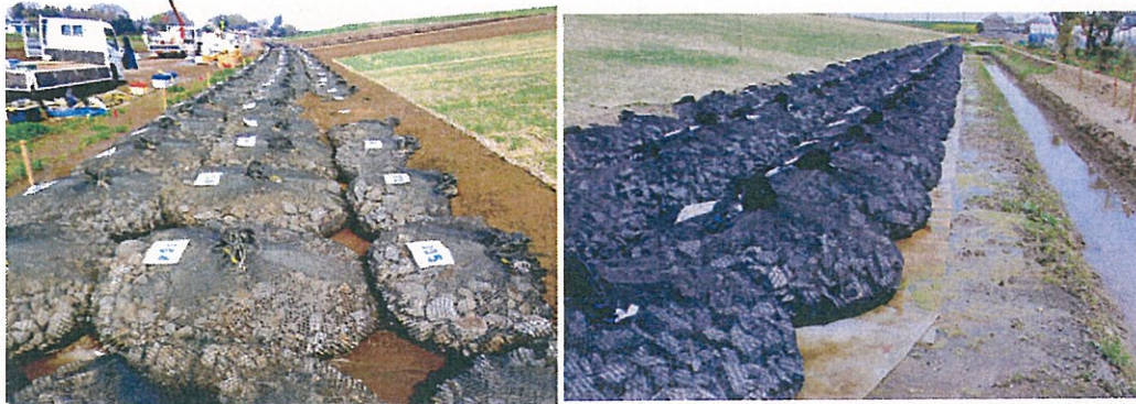
実験の対象地となる堤体法尻部分、日常的な水の染み出しが目立つ現場（埼玉県加須市新川地先）長雨や豪雨時には滑り出しも危惧される
