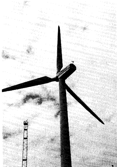
写真 風力発電機の例 (山形県立川町 撮影: 古田 剛)
