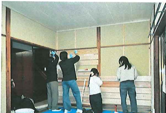
図 3-12.柵板を入れながら板材を取付ける
