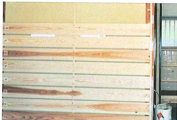
図 3-13.手製の目地棒を使い目地幅を統一する
