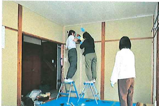
図 3-10.下地の胴縁を取り付ける
