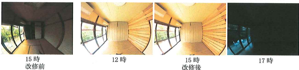
図 4-4. 1 階居室の明るさの変化(同一シャッタースピード 1/3200 で撮影)
