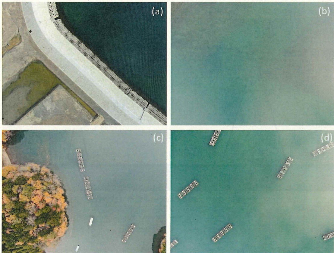
(図 4) 高度 140m からドローン撮影した写真の一部
