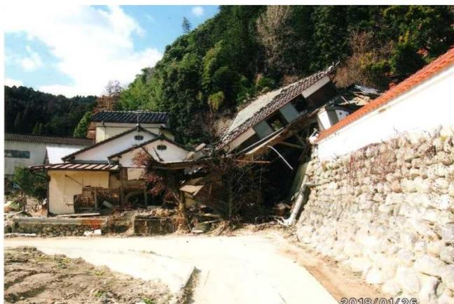
写真-2 土砂に押し流された新しい家屋 福岡県朝倉町
