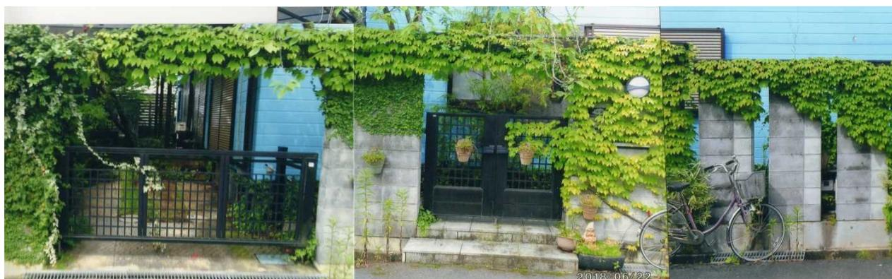
写真-5 ガレージ、門、壁はコンクリートブロックを積み、スリットを空け、臥梁は米杵
