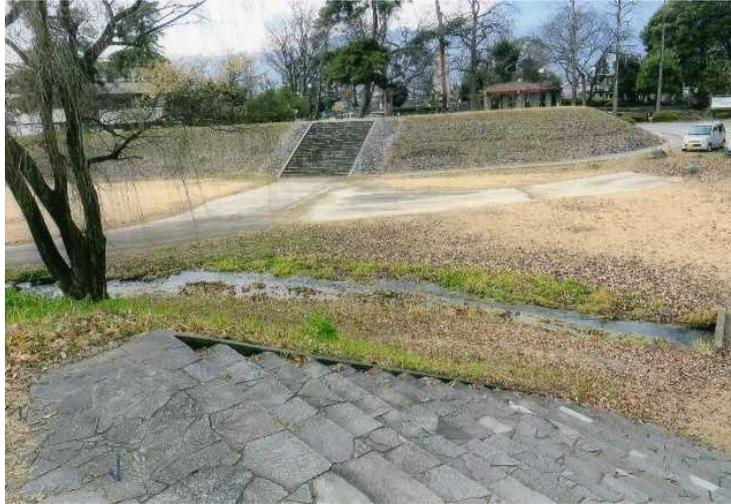
写真-3 霞堤 手前と向う側の堤防の間が開き、万力林の水がここから排水される
