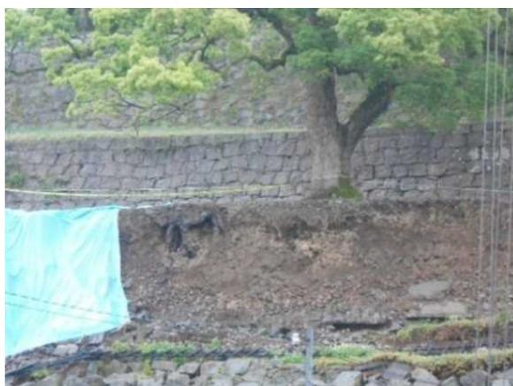
写真-15 崩壊した石積みの背後に見えたクスの根(再掲)
