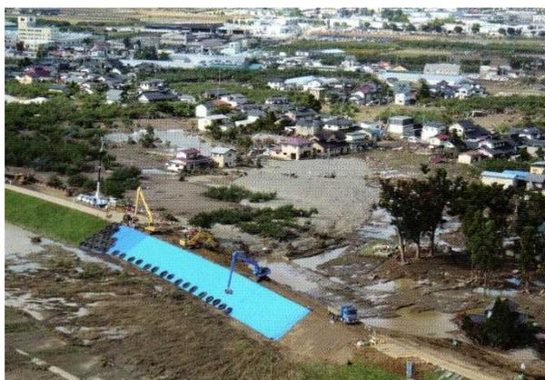
写真-7 突貫工事で完成した仮堤防(1)
