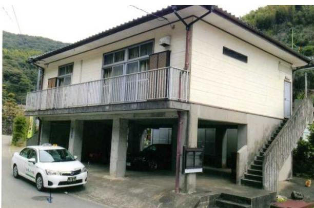
写真-5 ピロティが再発の土砂をいなす
