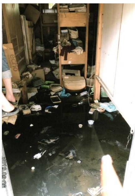
写真-2 住宅の床に溜まった油混じりの水
