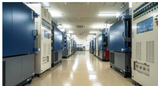
▲充放電専用チャンバーと電源 （とちぎバッテリー安全認証センター）
