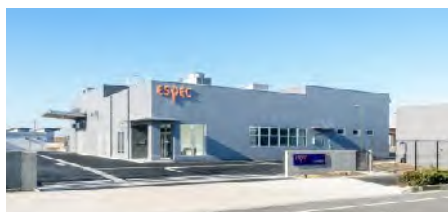
あいちバッテリー安全認証センター (愛知県常滑市)
