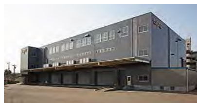
豊田試験所(愛知県豊田市)
