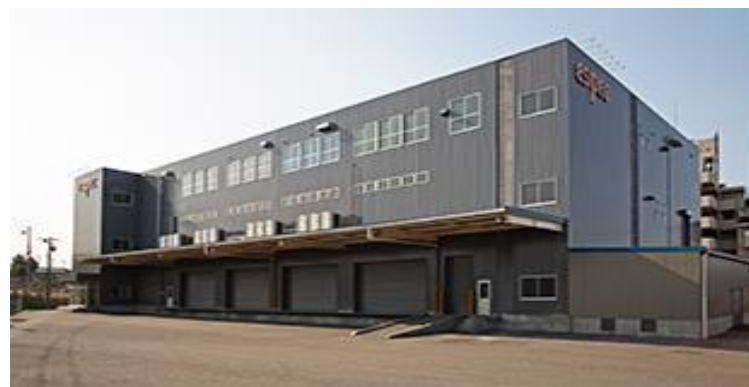
豊田試験所(愛知県豊田市)
