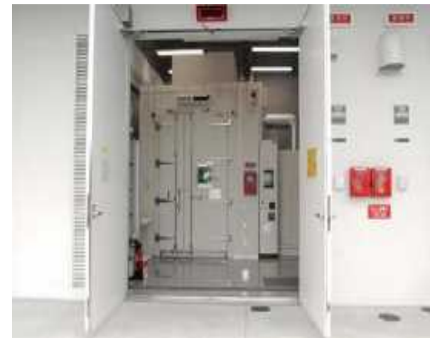
充放電試験用の恒温恒湿室
