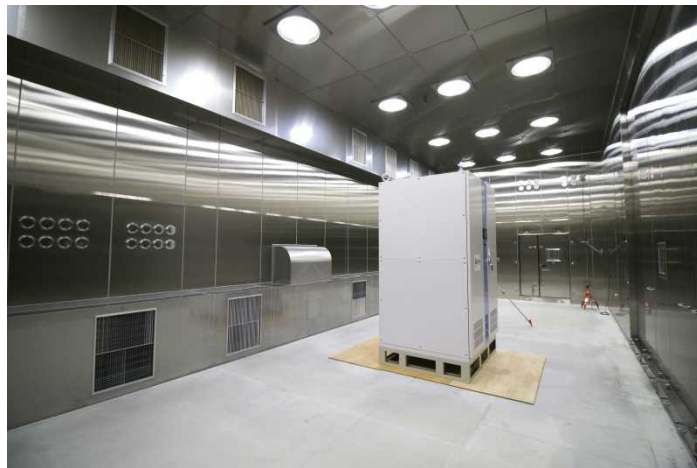
大型恒温恒湿室
