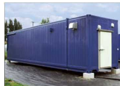
コンテナ式植物工場
