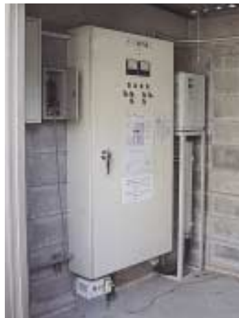
24時間稼働している工業用ポンプに、インバーターを取り付け
