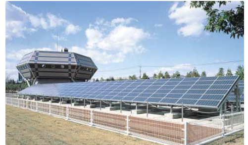
太陽光発電施設
