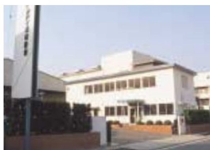
株式会社タバイ環境設備 (大阪府大東市)
