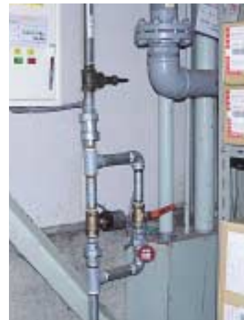
圧縮空気配管に電磁弁を取り付け、業務終了・非使用回路は自動的に遮断する
