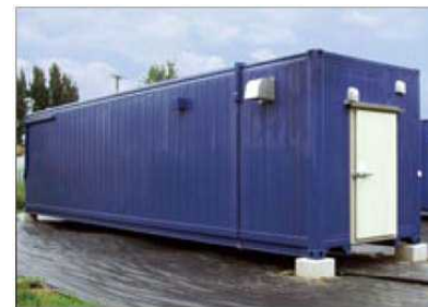
コンテナ式植物工場
