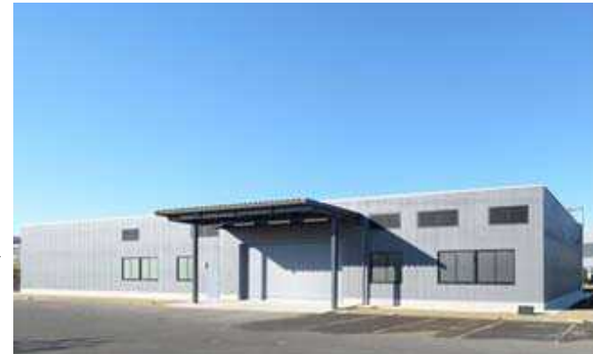
【Energy Device Environmental Test Center】
